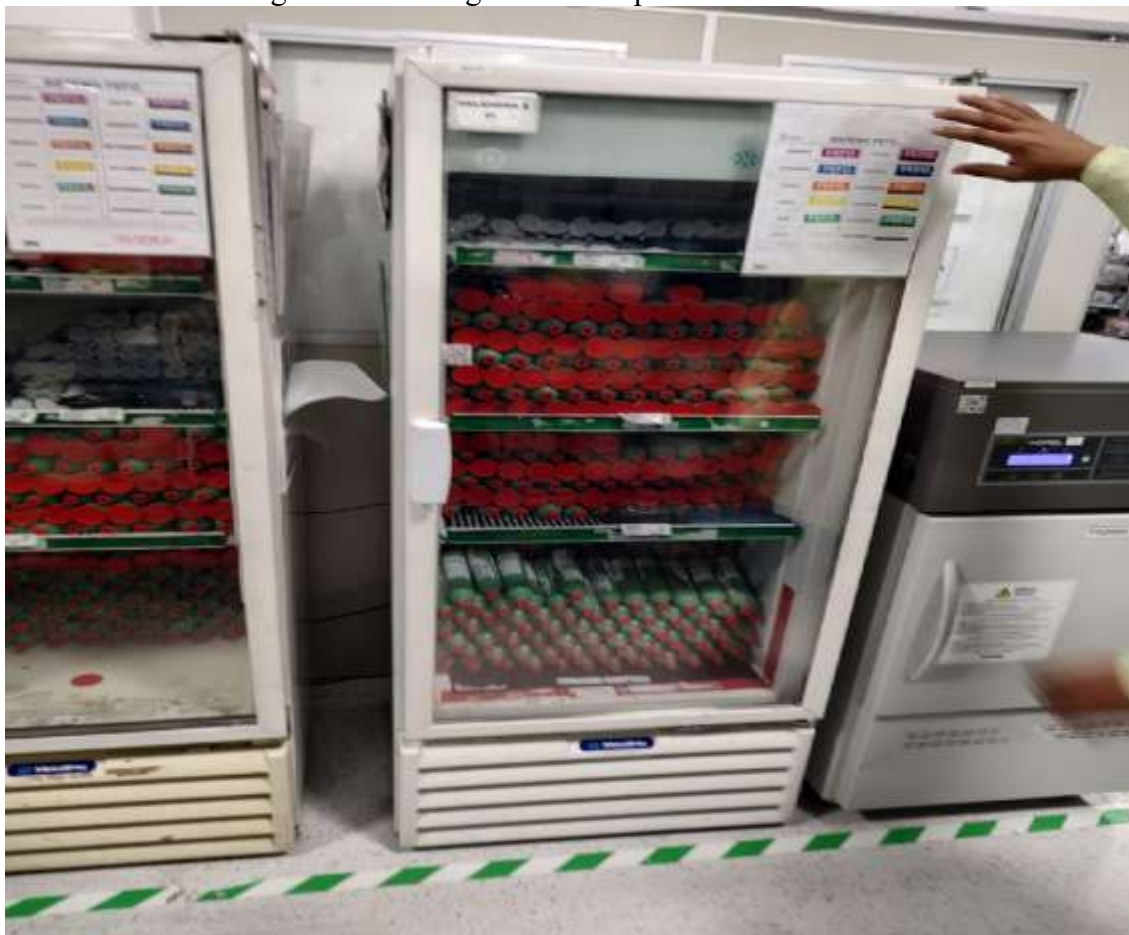
Figura 17 – Refrigerador com pasta de solda e cola
